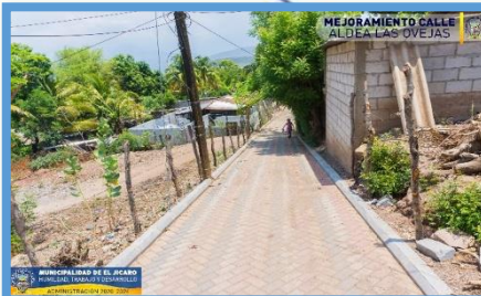
Año 2021 Mejoramiento calle ingreso colonia Bella Vista, Aldea Las Ovejas
