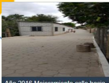
Año 2016 Mejoramiento calle hacia Salón Comunal, Aldea Espíritu Santo
