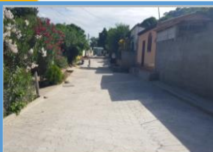
Año 2018 Construcción Sistema de Alcantarillado, Aldea Las Anonas
