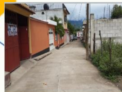
Año 2016 Mejoramiento calle, Lotificación Las Yargas
