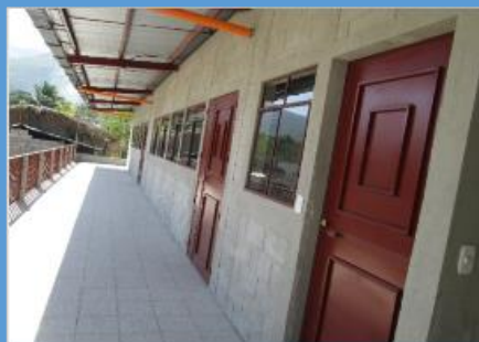
Año 2018 Construcción Escuela Primaria, Aldea Espiritu Santo
