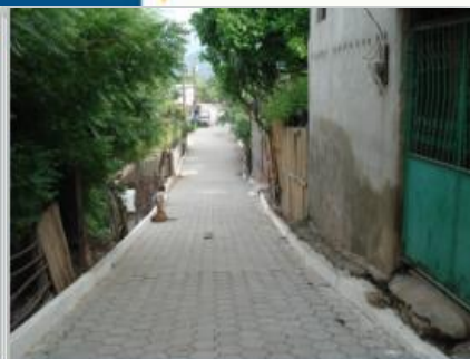
Año 2013 Mejoramiento Calles, Colonia Jorge Mario Barrios Falla
