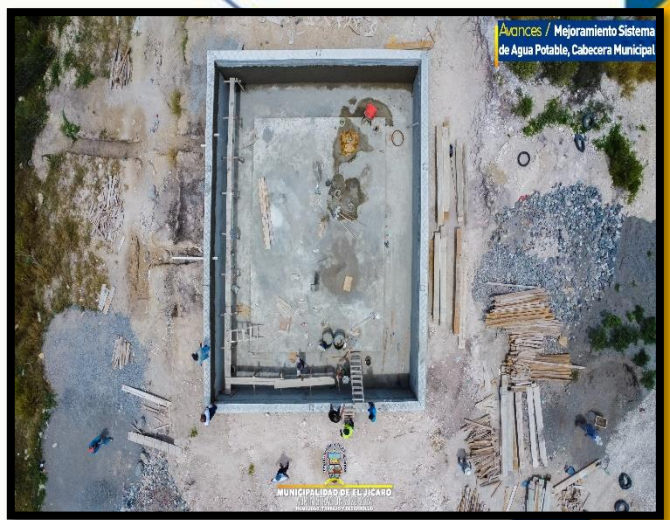
Avances / Mejoramiento Sistema de Agua Potable, Cabecera Municipal
