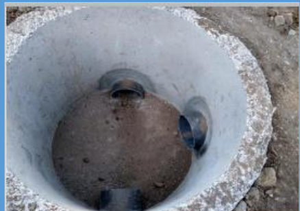
Año 2020 Ampliación de Alcantarillado, Aldea Las Ovejas
