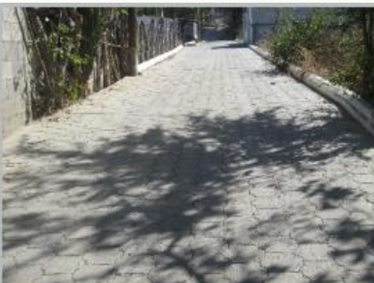
Año 2017 Ampliación Alcantarillado, Caserío Patio de Gallo
