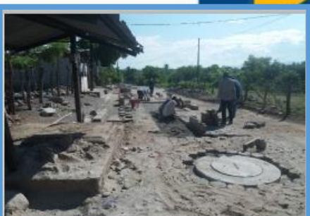
Año 2018 Construcción Alcantarillado, Aldea El Tambor
