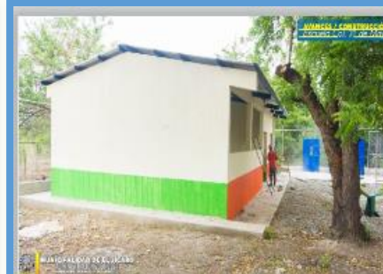
Año 2021 Construcción Escuela Pre-Primaria, Colonia 31 de Mayo
