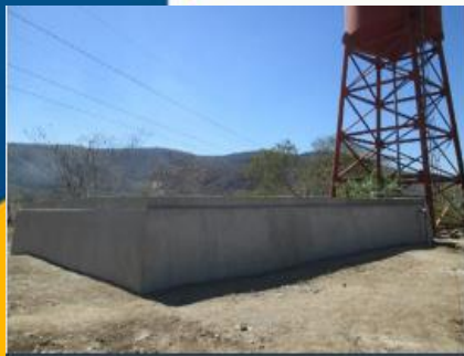
Año 2017 Mejoramiento Sistema de Agua Potable, Aldea El Paso
