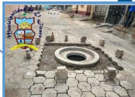
Año 2020 Construcción Alcantarillado, Aldea Agua Caliente
