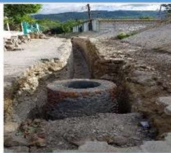
Año 2019 Construcción Alcantarillado, Aldea Los Bordes de Barillas
