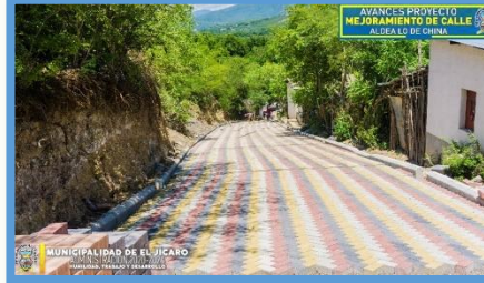
Año 2021 Mejoramiento calles, Aldea Lo De China
