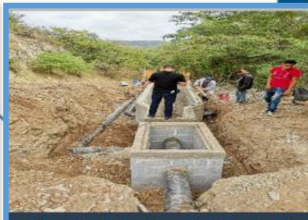
Año 2020 Construcción Planta de Tratamiento de Aguas Residuales, Aldea Los Bordos de Barillas
