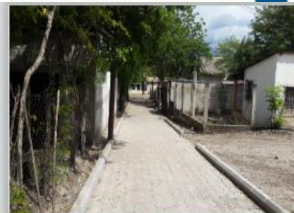
Año 2015 Mejoramiento calle, Aldea Ojo de Agua
