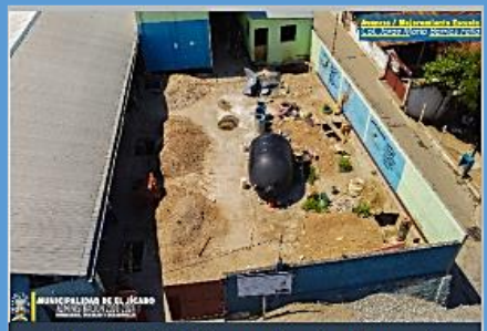
Año 2021 Mejoramiento Escuela Primaria, Colonia Jorge Mario Barrios Falla
