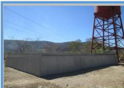
Año 2017 Mejoramiento Sistema de Agua Potable, Aldea El Paso
