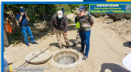
Año 2021 Construcción Alcantarillado Colonia Los Guayacanes, Aldea El Paso
