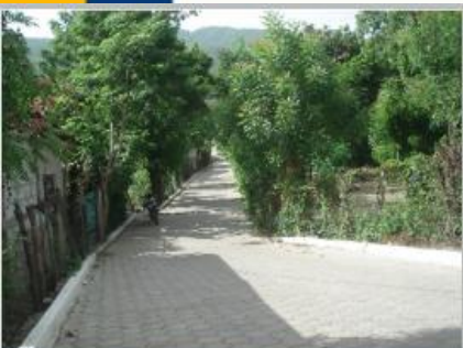
Año 2017 Mejoramiento calle, Colonia 31 de Mayo
