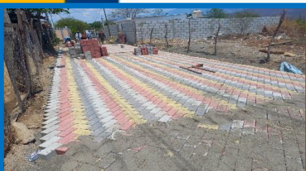
Año 2021 Mejoramiento Calle, Aldea El Zapote
