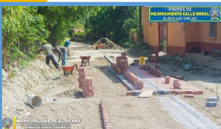
Año 2021 Mejoramiento calle rural, Aldea Las Ovejas
