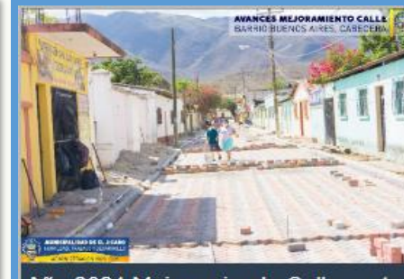
Año 2021 Mejoramiento Calle sector Señor Julio Ramirez, Barrio Buenos Aires
