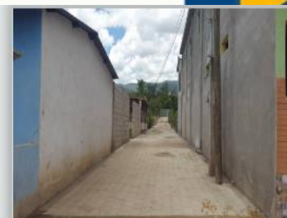
Año 2016 Mejoramiento calle, Caserío Patio de Gallo
