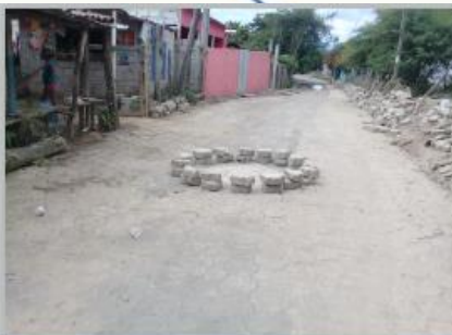
Año 2017 Mejoramiento Sistema de Alcantarillado, Aldea El Zapote
