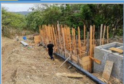
Año 2020 Construcción Planta de Tratamiento de Aguas Residuales, Aldea Los Bordos de Barillas
