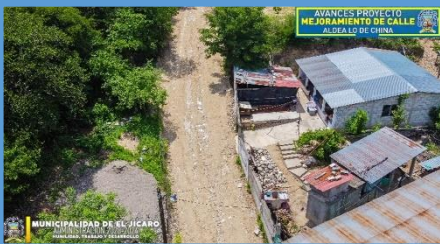
Año 2021 Mejoramiento calles, Aldea Lo De China
