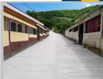
Año 2017 Mejoramiento calle hacia Salón Comunal, Aldea Santa Rosalia
