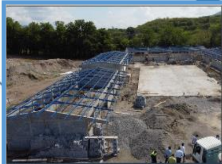
Año 2021 Construcción Instituto Tecnológico, Barrio Buenos Aires
