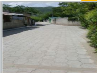
Año 2016 Mejoramiento calle, Colonia 31 de Mayo
