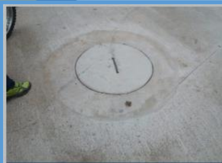
Año 2018 Mejoramiento Sistema de Alcantarillado, Aldea El Zapote
