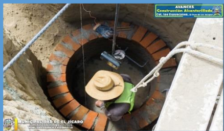
Año 2021 Construcción Alcantarillado Colonia Los Guayacanes, Aldea El Paso
