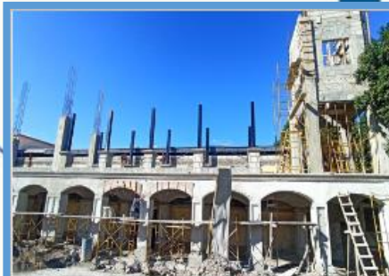
Año 2021 Mejoramiento Edificio Municipal, Barrio El Centro
