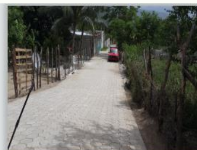
Año 2016 Mejoramiento calle, Caserío Patio de Gallo
