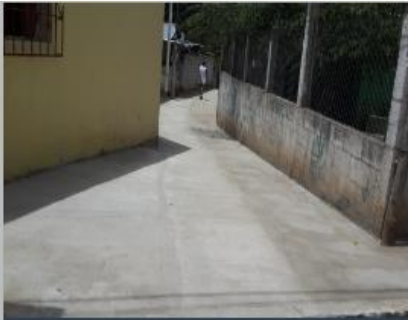
Año 2016 Mejoramiento Calle, Aldea Los Bordos de Barillas
