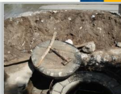
Año 2013 Construcción Sistema de Alcantarillado, Aldea El Zapote
