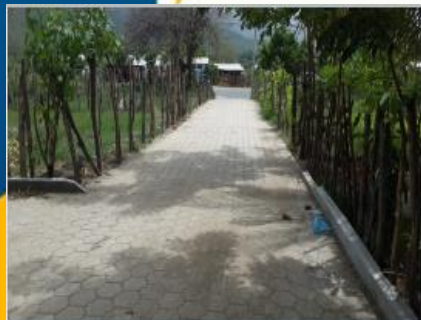
Año 2015 Mejoramiento calle, Caserío Patio de Gallo
