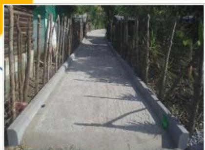
Año 2017 Mejoramiento calle colonia Bella Vista, Aldea Las Ovejas
