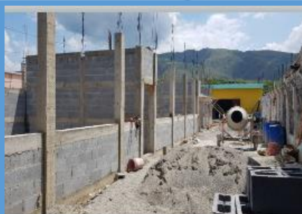
Año 2019 Mejoramiento Escuela Pre-Primaria, Barrio Buenos Aires
