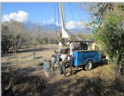
Año 2017 Mejoramiento Sistema Agua Potable, Aldea El Tambor
