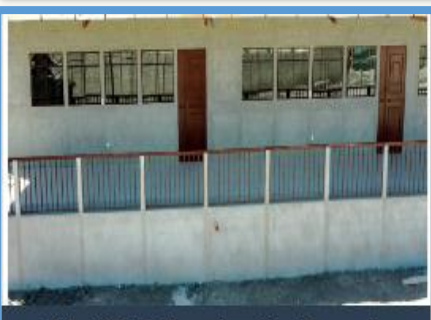
Año 2018 Construcción Escuela Primaria, Aldea Espiritu Santo
