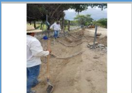
Año 2019 Ampliación Alcantarillado, Caserío Patio de Gallo
