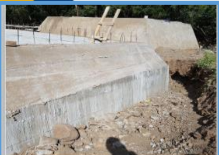
Año 2017 Ampliación Sistema de Agua Potable, Aldea Agua Caliente
