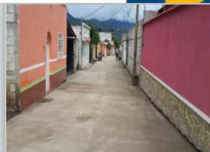
Año 2015 Mejoramiento calle, Lotificación Las Yardas
