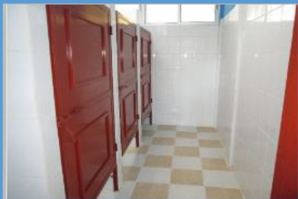
Año 2018 Mejoramiento Instituto Juan Ramon Bracamonte, Barrio Buenos Aires
