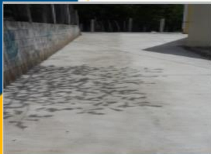
Año 2015 Mejoramiento Calle, Aldea Los Bordos de Barillas
