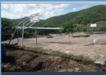
Año 2018 Mejoramiento de Techo, Escuela Primaria, Aldea Agua Caliente
