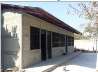
Año 2015 Construcción Escuela Pre-Primaria, Aldea Los Bordos de Barillas
