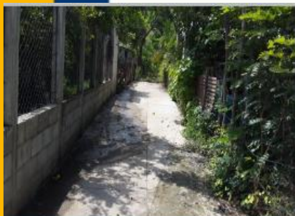
Año 2015 Mejoramiento calle, Aldea Ojo de Agua
