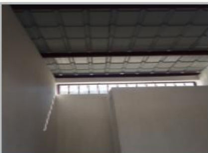
Año 2015 Construcción Salón Comunal, Aldea Santa Rosalía
