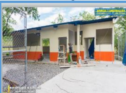
Año 2021 Construcción Escuela Pre-Primaria, Colonia 31 de Mayo
