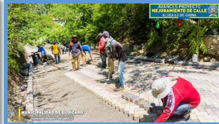
Año 2021 Mejoramiento calles, Aldea Lo De China
