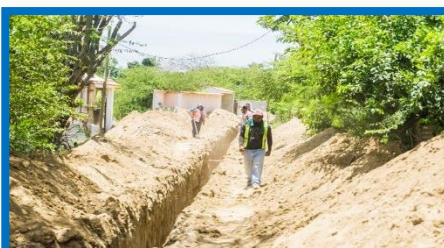
Año 2021 Mejoramiento Sistema Agua Potable, Colonia Jorge Mario Barrios Falla
