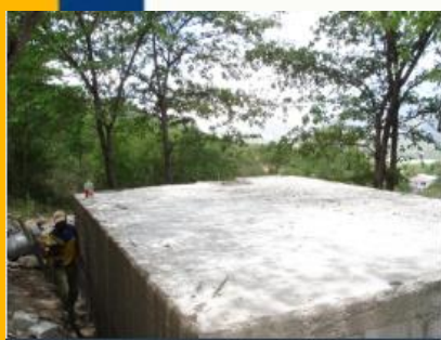
Año 2013 Mejoramiento Sistema Agua Potable, Aldea El Tambor
