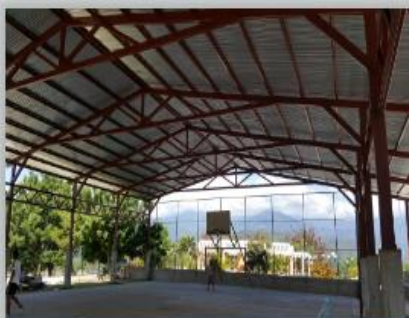
Año 2016 Mejoramiento Techo de Cancha Polideportiva, Aldea El Paso
