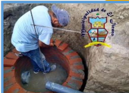
Año 2020 Ampliación Alcantarillado, Caserio Patio de Gallo
