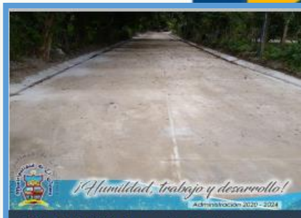
Año 2020 Mejoramiento Camino de ingreso, Colonia Jorge Mario Barrios Falla
