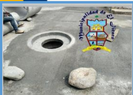
Año 2020 Construcción Alcantarillado, Aldea Agua Caliente
