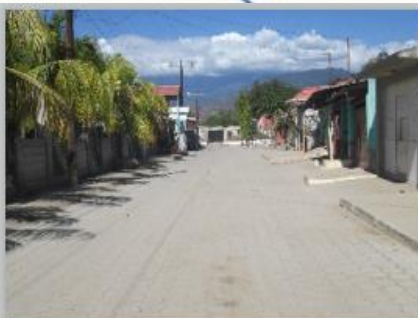
Año 2017 Mejoramiento Calles, Colonia Jorge Mario Barrios Falla
