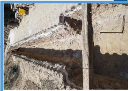
Año 2019 Ampliación Alcantarillado, Aldea El Tambor
