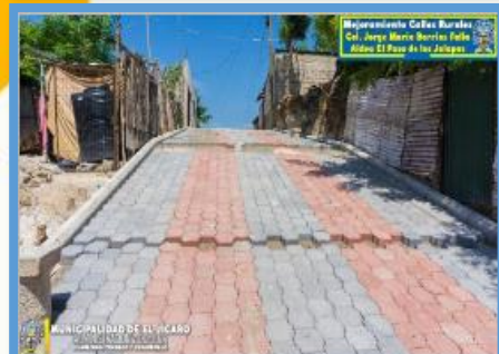
Año 2021 Mejoramiento Calles, Colonia Jorge Mario Barrios Falla
