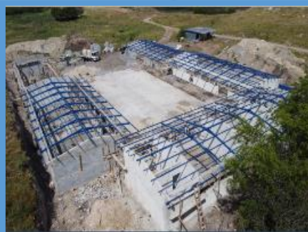
Año 2021 Construcción Instituto Tecnológico, Barrio Buenos Aires
