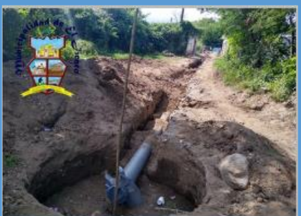
Año 2020 Ampliación Alcantarillado, Caserio Patio de Gallo
