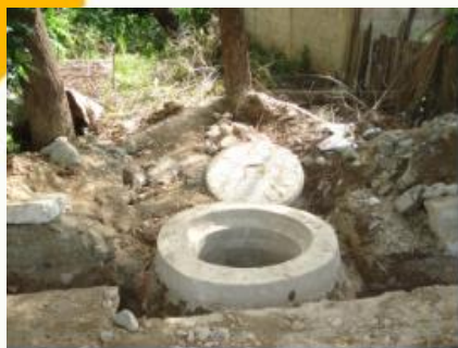
Año 2014 Construcción Sistema de Alcantarillado, Aldea El Zapote
