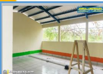
Año 2021 Construcción Escuela Pre-Primaria, Colonia 31 de Mayo
