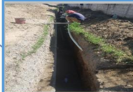
Año 2019 Ampliación Alcantarillado, Caserío Patio de Gallo
