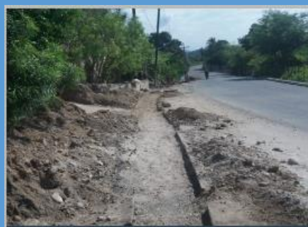
Año 2018 Construcción Alcantarillado, Aldea El Tambor
