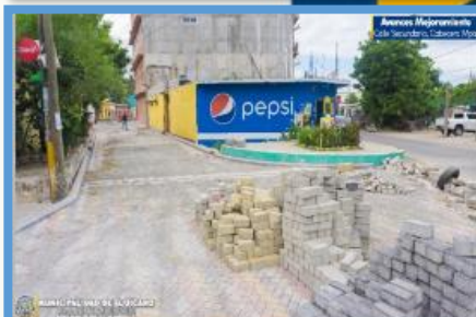
Años Mejoramiento calle secundaria detras Parque Centenario, Barrio El Centro
