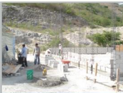
Año 2014 Construcción Salón Comunal, Aldea Santa Rosalía
