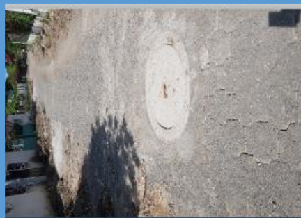
Año 2019 Construcción Alcantarillado Aldea Las Ovejas
