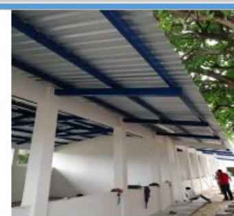
Año 2019 Mejoramiento Instituto Diversificado, Barrio Buenos Aires
