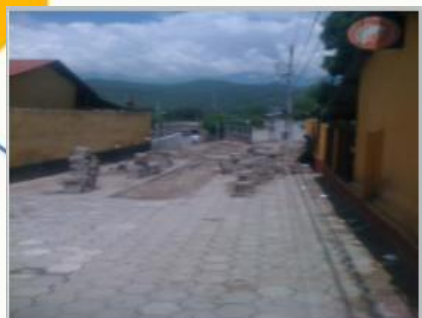
Año 2013 Ampliación Sistema de Alcantarillado, Aldea Lo De China
