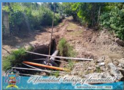
Año 2020 Ampliación Alcantarillado, Caserio Patio de Gallo
