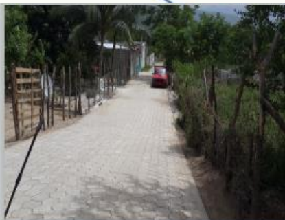
Año 2015 Mejoramiento calle, Caserío Patio de Gallo
