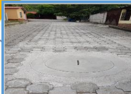
Año 2019 Ampliación Alcantarillado, Aldea Las Anonas
