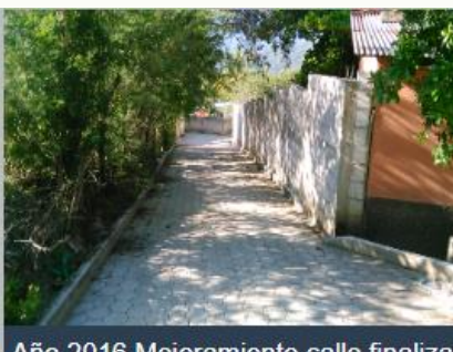
Año 2016 Mejoramiento calle finaliza en vivienda de Sr Nicolas Marroquín, Aldea Las Anonas
