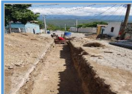
Año 2019 Ampliación Alcantarillado, Aldea Las Anonas
