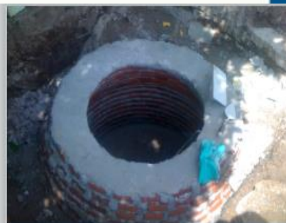
Año 2013 Ampliación Sistema Alcantarillado, Aldea El Paso
