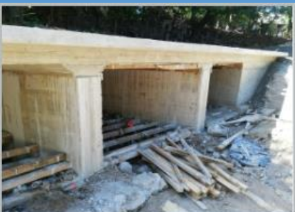
Año 2020 Mejoramiento camino rural con Baden, Aldea Lo De China
