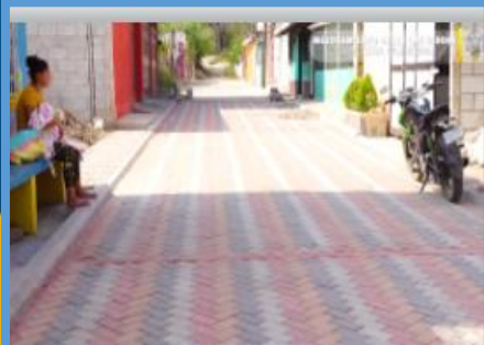
Año 2021 Mejoramiento calle, Lotificación Las Yargas
