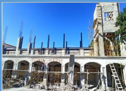
Año 2021 Mejoramiento Edificio Municipal, Barrio El Centro
