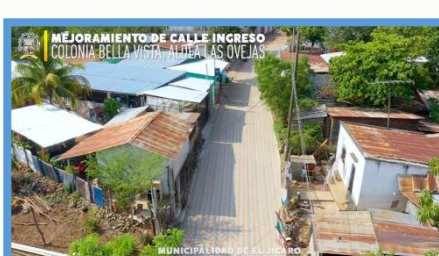
Año 2021 Mejoramiento calle ingreso colonia Bella Vista, Aldea Las Ovejas
