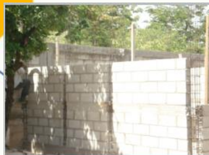
Año 2014 Construcción Escuela Pre-Primaria, Aldea Los Bordos de Barillas
