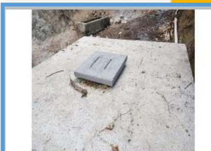
Año 2019 Mejoramiento Sistema de Agua Potable, Aldea Las Anonas
