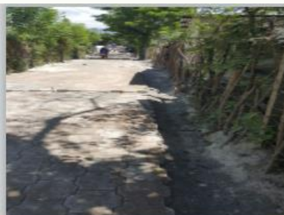
Año 2016 Mejoramiento calle, Colonia 31 de Mayo
