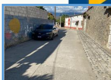
Año 2021 Mejoramiento calle, Lotificación Las Yardas
