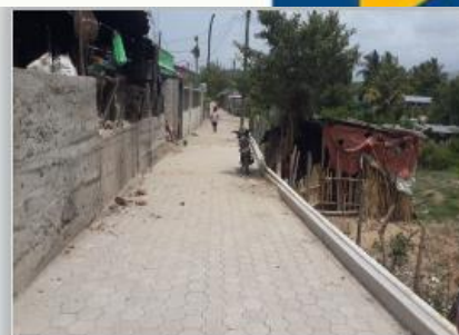
Año 2015 Mejoramiento calle hacia Salón Comunal, Aldea Espíritu Santo
