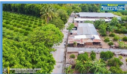
Año 2021 Mejoramiento calle rural, Aldea Las Ovejas
