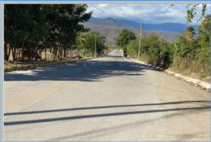
Año 2021 Mejoramiento calle por el puente ingreso a El Jícaro, Barrio Santa Cruz
