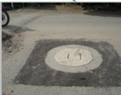
Año 2013 Ampliación Sistema Alcantarillado, Aldea El Paso
