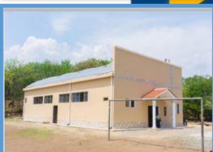
Año 2020 Construcción Salón Comunal, Aldea El Tambor
