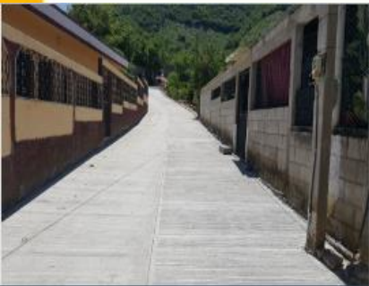
Año 2016 Mejoramiento calle Salón Comunal, Aldea Santa Rosalia
