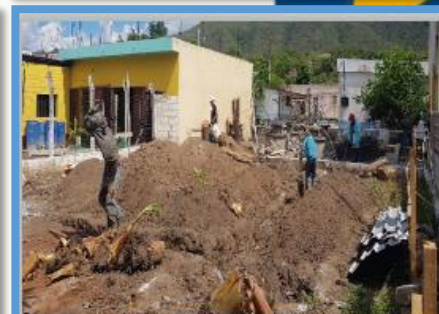
Año 2019 Mejoramiento Instituto Diversificado, Barrio Buenos Aires
