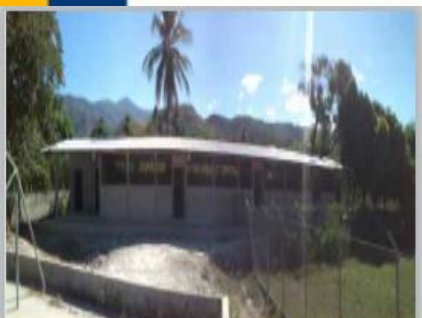
Año 2013 Construcción Instituto Basico, Aldea Las Ovejas
