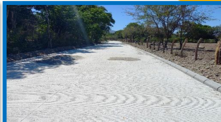
Año 2021 Mejoramiento camino ingreso, Aldea Las Ovejas
