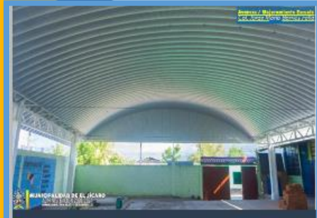
Año 2021 Mejoramiento Escuela Primaria, Colonia Jorge Mario Barrios Falla
