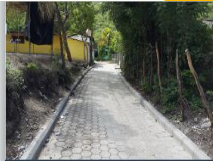
Año 2016 Mejoramiento calle, Aldea Ojo de Agua
