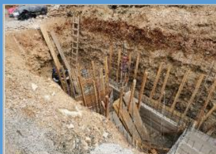
Año 2020 Construcción Sistema Aguas Residuales, Aldea Las Anonas
