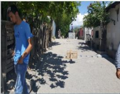
Año 2016 Mejoramiento Calles, Colonia Jorge Mario Barrios Falla
