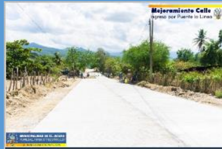
Año 2021 Mejoramiento calle por el puente ingreso a El Jícaro, Barrio Santa Cruz
