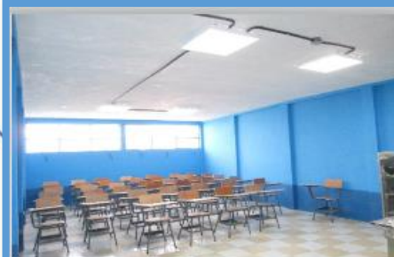
Año 2018 Mejoramiento Instituto Juan Ramon Bracamonte, Barrio Buenos Aires
