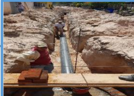
Año 2019 Construcción Alcantarillado, Aldea Las Ovejas
