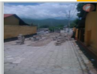
Año 2013 Ampliación Sistema de Alcantarillado, Aldea Lo De China
