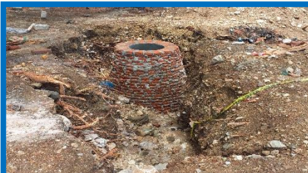
Año 2021 Ampliación Sistema Alcantarillado parte baja, Aldea Las Anonas
