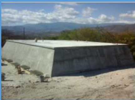
Año 2018 Construcción de Tanque Agua Potable, Aldea El Zapote
