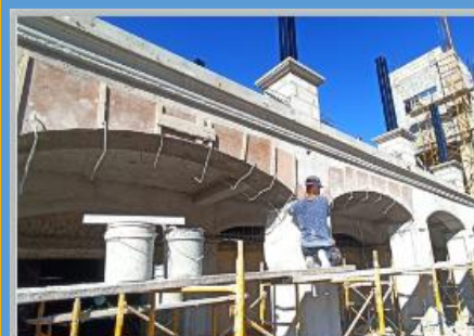
Año 2021 Mejoramiento Edificio Municipal, Barrio El Centro
