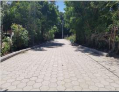
Año 2016 Mejoramiento calle hacia colonia Vista Bella, Aldea Las Ovejas
