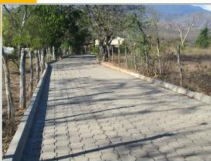
Año 2017 Mejoramiento de calle hacia Iglesia, Aldea El Tambor
