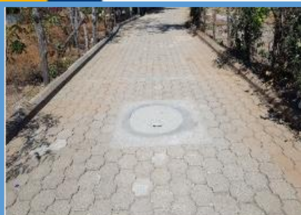
Año 2019 Ampliación Alcantarillado, Aldea El Tambor
