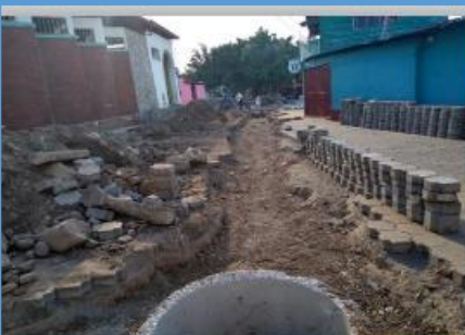
Año 2020 Ampliación de Alcantarillado, Aldea Las Ovejas
