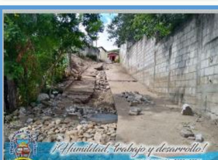
Año 2020 Construcción Alcantarillado, Aldea Agua Caliente
