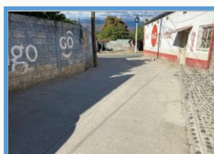
Año 2021 Mejoramiento calle, Lotificación Las Yardas
