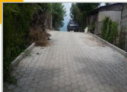
Año 2015 Mejoramiento calle, Colonia 31 de Mayo
