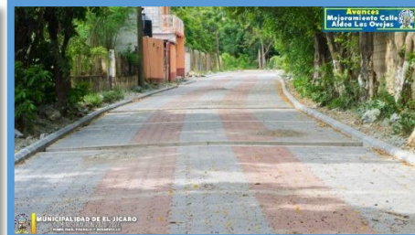
Año 2021 Mejoramiento calle rural, Aldea Las Ovejas
