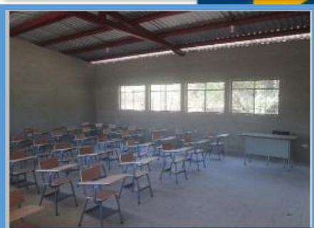
Año 2018 Construcción Escuela Primaria, Aldea Espiritu Santo
